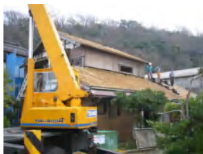
解体取り壊し作業
